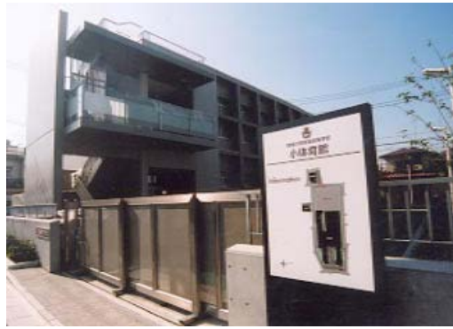
▲道路をはさんで小体育館も。柔道場、卓球場、多目的運動場を備える。
