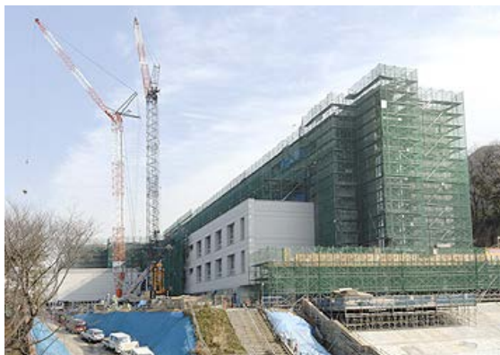
▲一部防護ネットがはずされ、石張りの外壁が姿を現した生田10号館(仮称)
