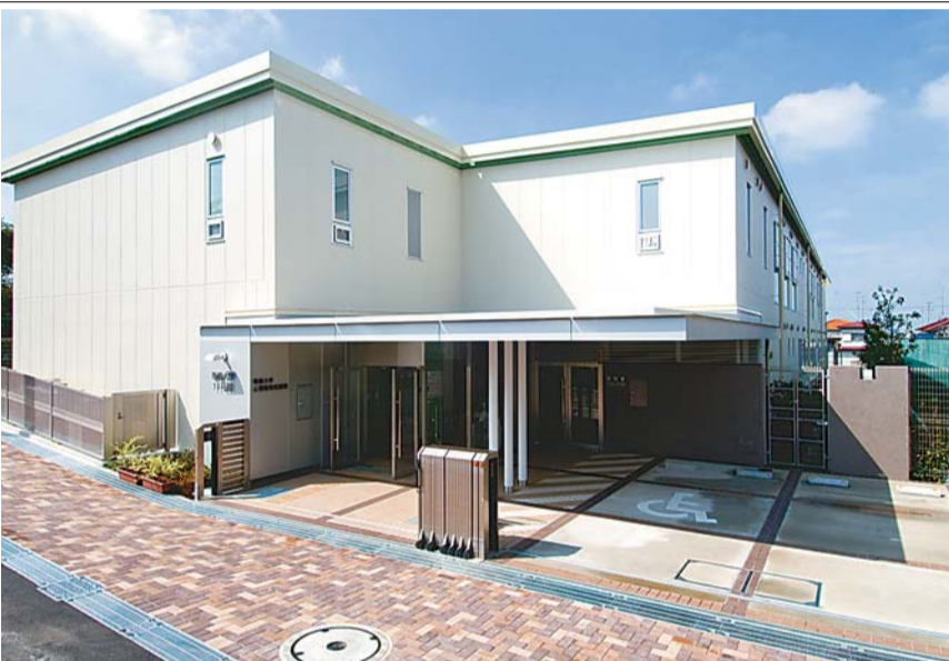
▲ 鉄骨造2階建て、延べ床面積1558.48㎡。2階には教員用の研究室が20室ある
