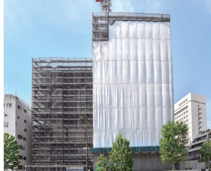
建設が進む靖国通り神田新校舎(仮称)。右後ろは1号館。5月12日。
